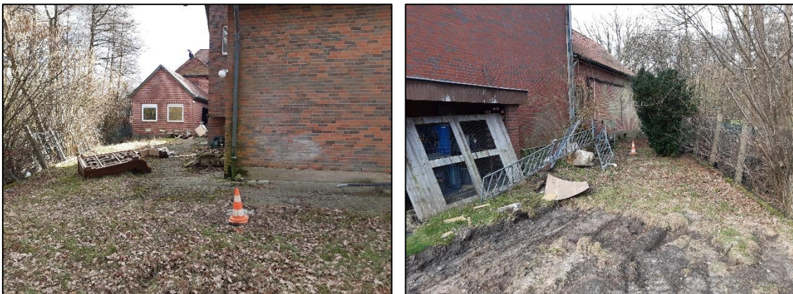
Bild 1 und Bild 2: Ansichten des Baugrundstückes und exemplarischer Bohransatzpunkte (li: KRB 1; re: KRB 3)
