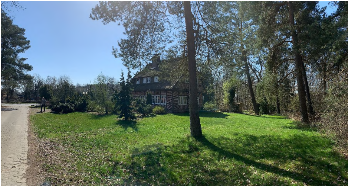
Abb. 3: Blick von Nord-West
