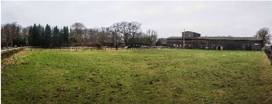
Abb.45: Blick von der Süd-Ost-Ecke
